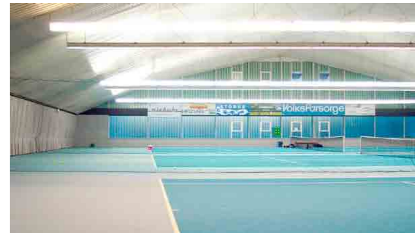
TSC Glashütte, Hamburg – Vergleich: über den hinteren beiden Feldern ARTEKO® LED-Leuchtröhren über vorderem Feld noch nicht umgerüstet, konventionelle Leuchtstoffröhren
